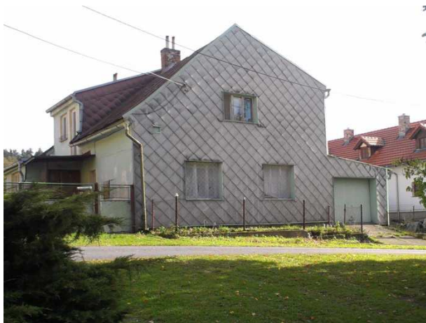
Nevhodná stavební úprava usedlosti
